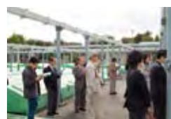
山形市浄化センター
